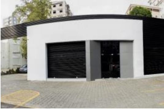
Edificio Av. Abraham Lincoln No. 1061
