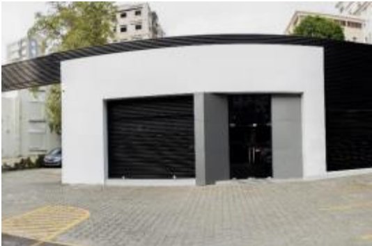
Edificio Av. Abraham Lincoln No. 1061
