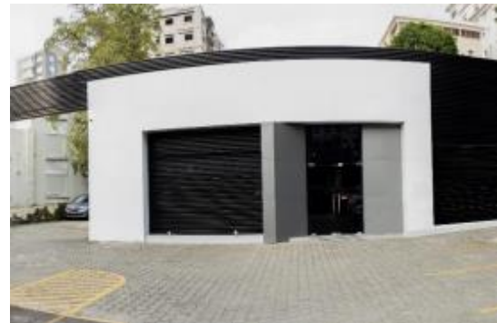
Edificio Av. Abraham Lincoln No. 1061
